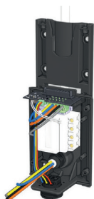
4. Usunięcie izolacji z kabla
